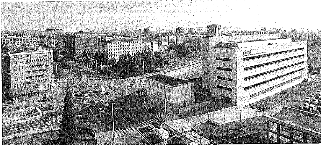
Edificio de CIMA ubicado en Pamplona donde investigan los medicamentos que desarrolla Digna
